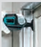
Retirada del marco de ventanas
