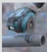
Corte de tubos de PVC
