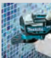
Encaje de juntas en revestimiento cerámico
